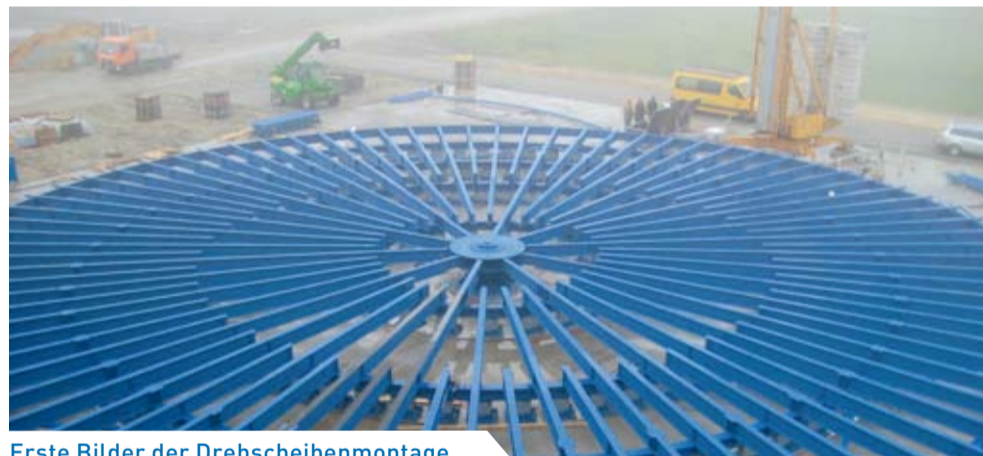
Erste Bilder der Drehscheibenmontage
